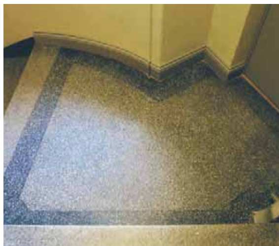
Terrazzo, även kallad cementmosaik eller konstbetong, består av krossad marmor, kalksten eller ett annat hårdare material, cement och eventuellt pigment. Här ser vi ett terrazzogolv från 1913.
