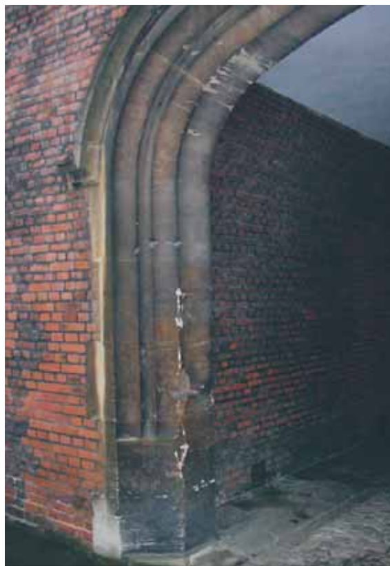
Bilden visar ett engelskt stenvallv med anor från 1500-talet. Skadorna uppstod när man ville köra in en last som var för stor. FOTO: LISA NILSEN.
