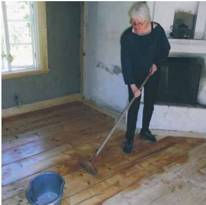
Skura golvet i träets längdriktning med skurborste på skaft.
