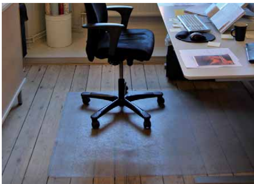
I Södra Bankohuset har man lagt in ett underlag i plast för att skydda golven.
