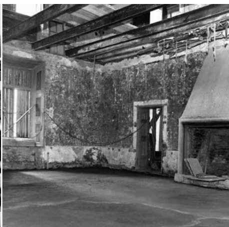
1970-talets betonggolv och stålbalksförstärkningar.
