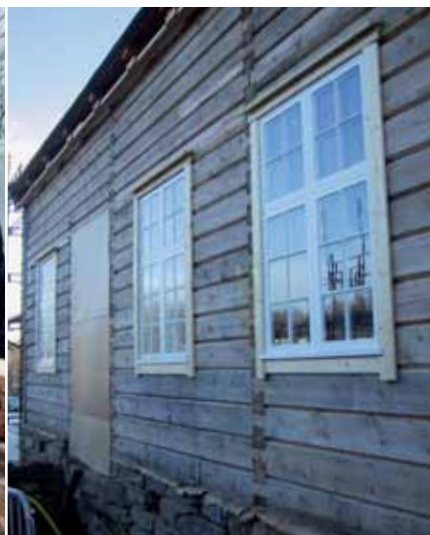
170 år efter att de brunnit byggdes de båda flyglarna upp igen efter originalritningarna och med traditionella material och metoder.
