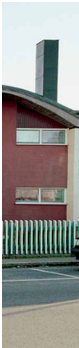
Fasaden har lyfts fram på hissutbyggnaden. Det gamla trapphusets ljusinsläpp finns kvar som blindfönster på den nya fasaden.
