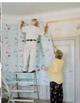
Montering av tapeter på trälistor.
