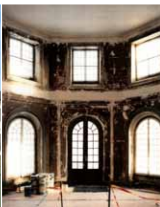
Salongen under restaureringsarbetet.
