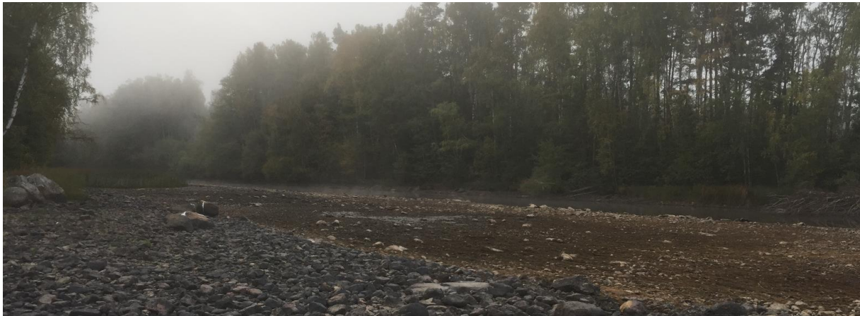
Figur 10: Utloppskanalen ur Salen ner mot Huseby, fotot taget vid extremt låga vattennivåer. De flacka kanalkanterna syns tydligt.
