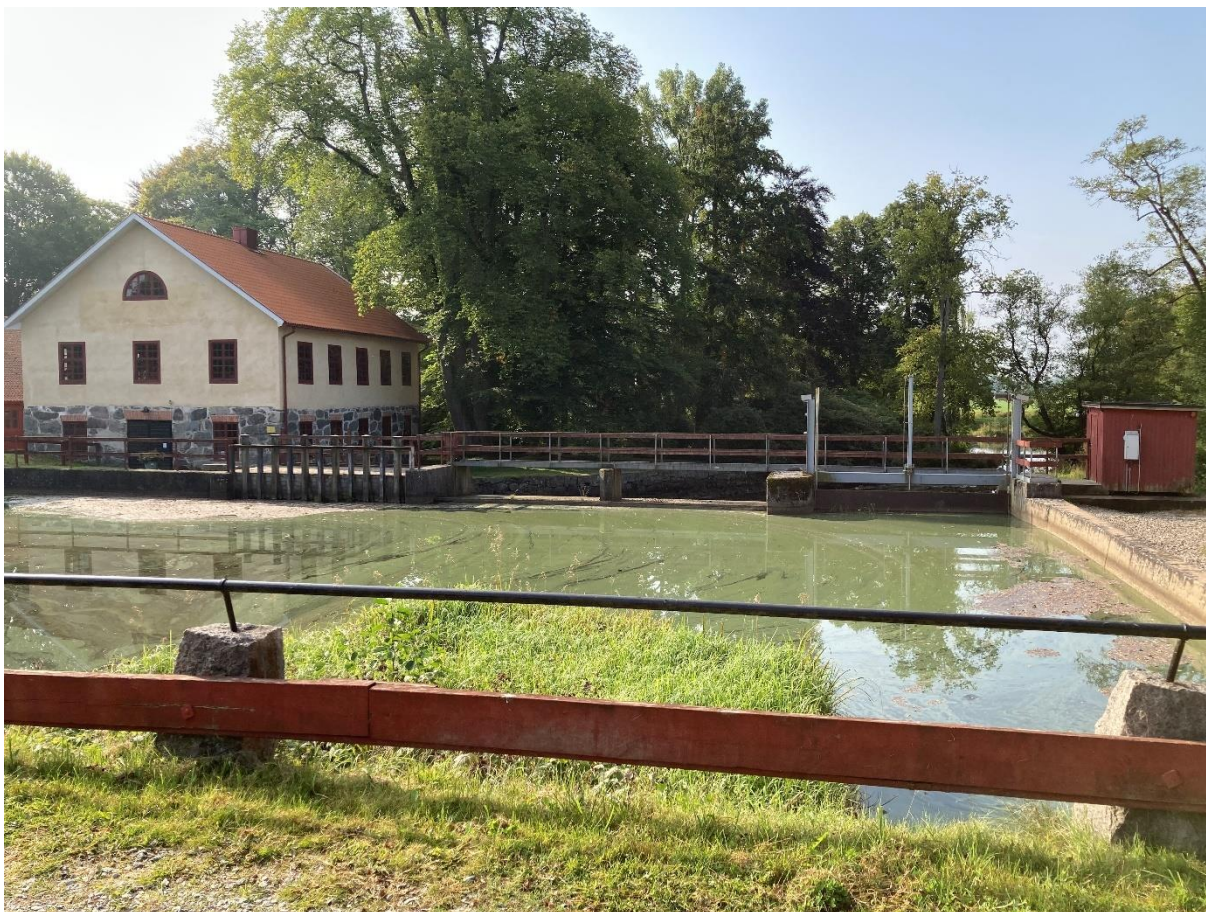
Figur 11: "Närdammen" mellan stenvälsbron, utskov och skibord. Vy mot söder från stenvälsbron. Foto WSP.
