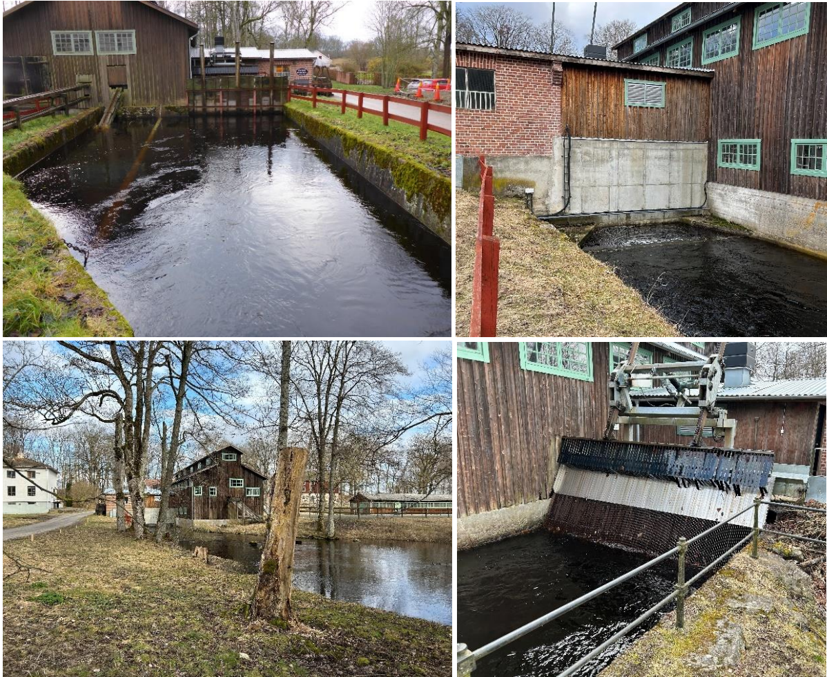
Figur 7: Damm och intag till kraftverket (övre vänstra hörnet), utlopp ur kraftverket (övre högra hörnet), vattenmiljön nedströms kraftverket (nedre vänstra hörnet) samt galler vid kraftverkets intag (nedre högra hörnet). Foto WSP.
