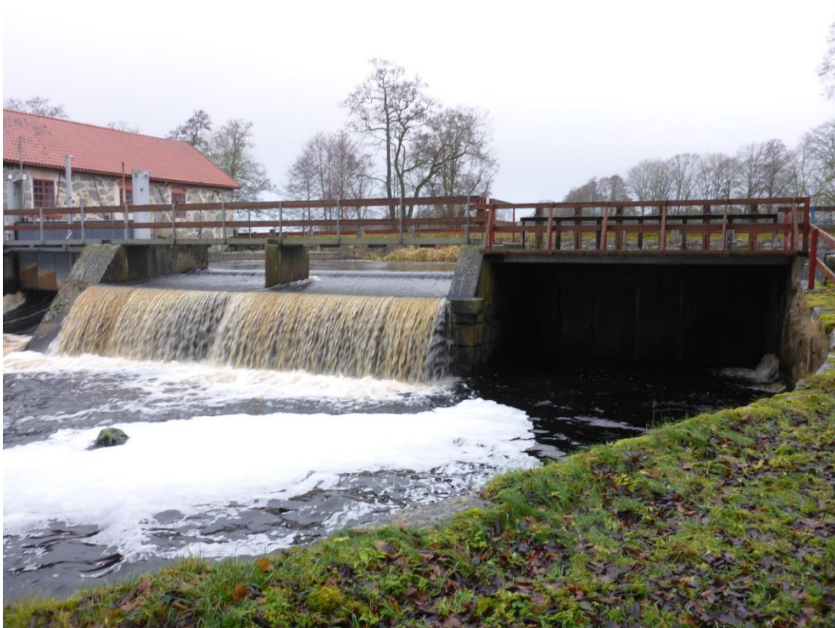
Figur 8: Skibordet med vattenöverfall. I bakgrunden till vänster ses kvarnbyggnaden. Foto WSP.
