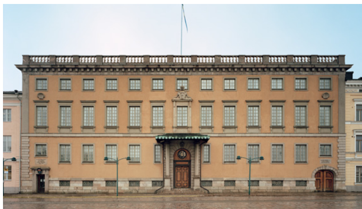
Grundförstärkning och renovering påbörjas av Sveriges ambassad i Helsingfors. Foto: Åke E:son Lindman
