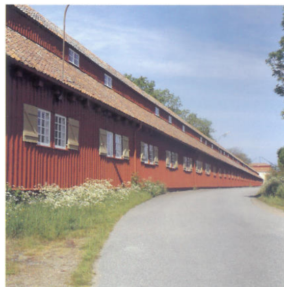
I närheten av Marinmuseet finns den välbevarade Repslagarebanan – en mer än 300 meter lång byggnad uppförd 1696.
