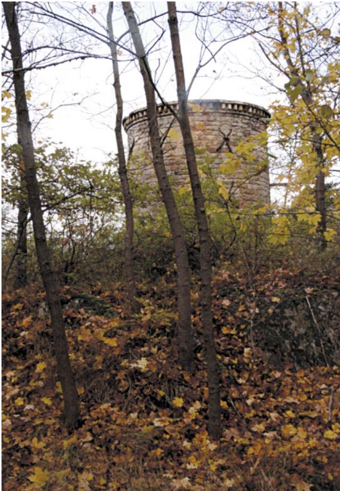
På Torphagens högsta punkt står ett tidigare utsikts- och vattentorn som ett dekorativt och romantiskt inslag.
