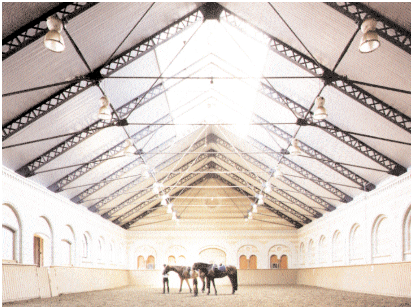
Ridhuset med sin blandning av stram klassicism och funktionell gjutjärnsarkitektur har fått ett underlag av sand och oorganiska fibrer för hästarna att springa på.
