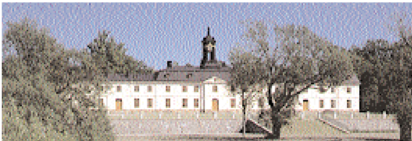
Svartsjö slott på Färingsö har återfått sin ljusa 1700-talsfasad med ockrafärgade snickerier. Mot sjösidan har terrassmuren med sitt räcke av smidesjärn återuppstätt och nu är även interiören färdigrenoverad.
