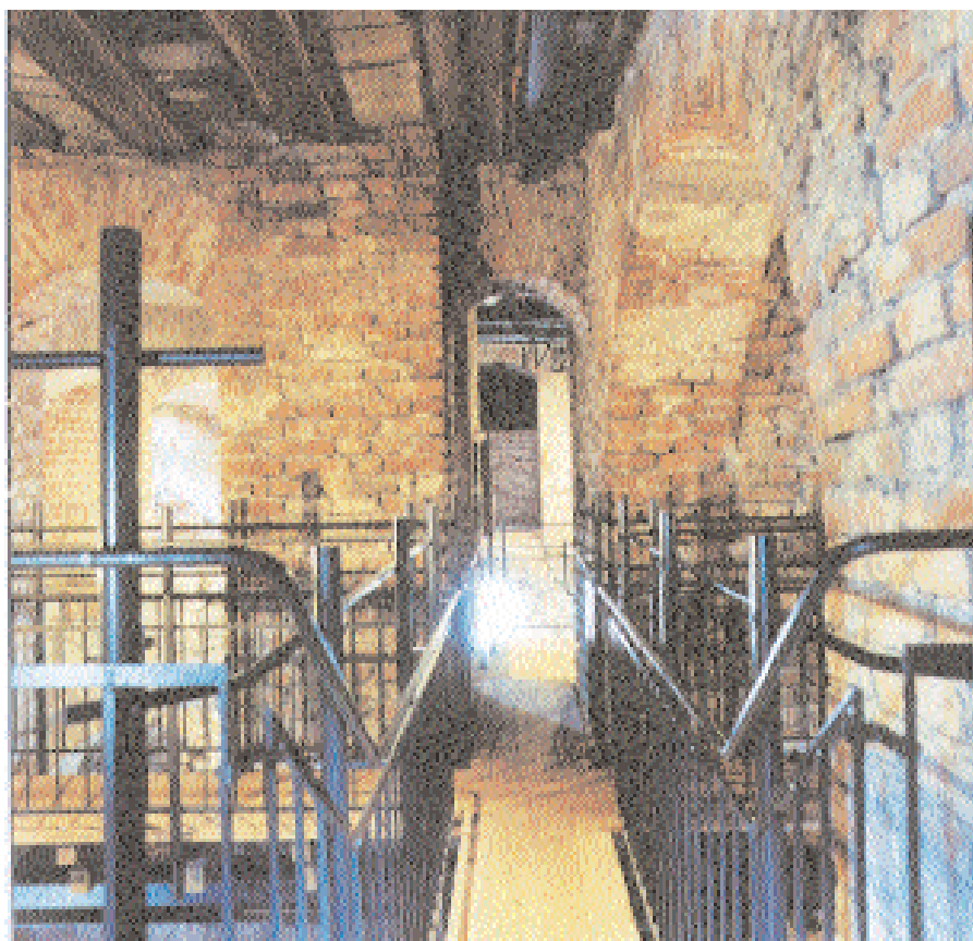
Gunnar Mattssons entresolkonstruktion har på ett tilltalande sätt integrerats i tornet utan att störa murverket.
