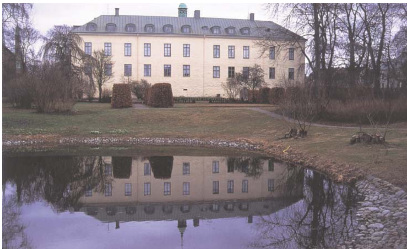
Slottets fasad mot väster i dag.
