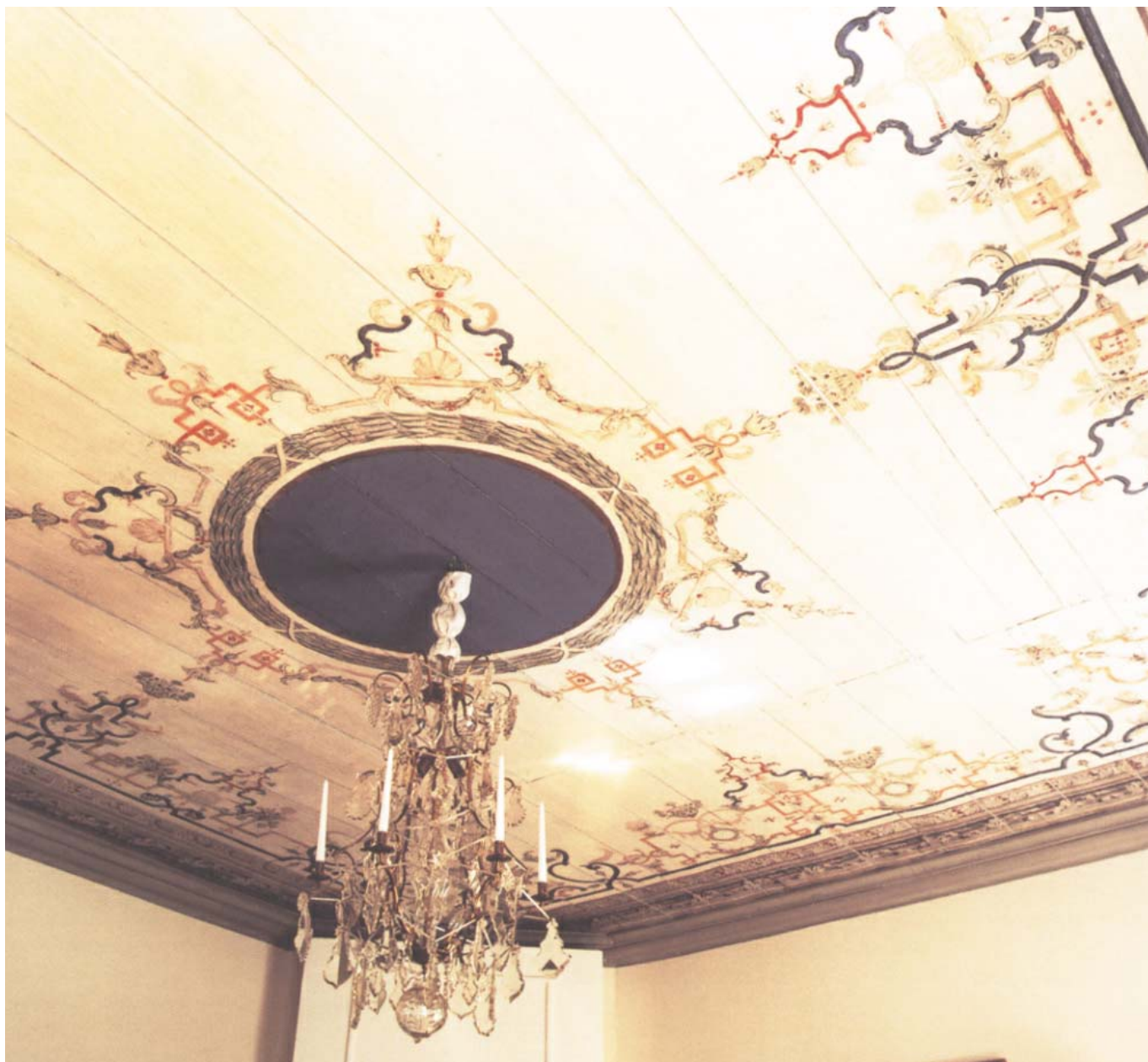
Det dekorerade 1700-talstaket togs fram och renoverades på 1950-talet.
