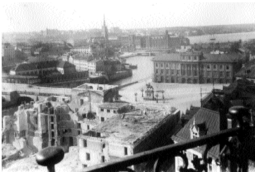
År 1891 inleddes rivningen av Gustav III:s operahus från 1782. Det var då även aktuellt att riva Arvfurstens palats och ersätta det med ett modernt affärshus.
