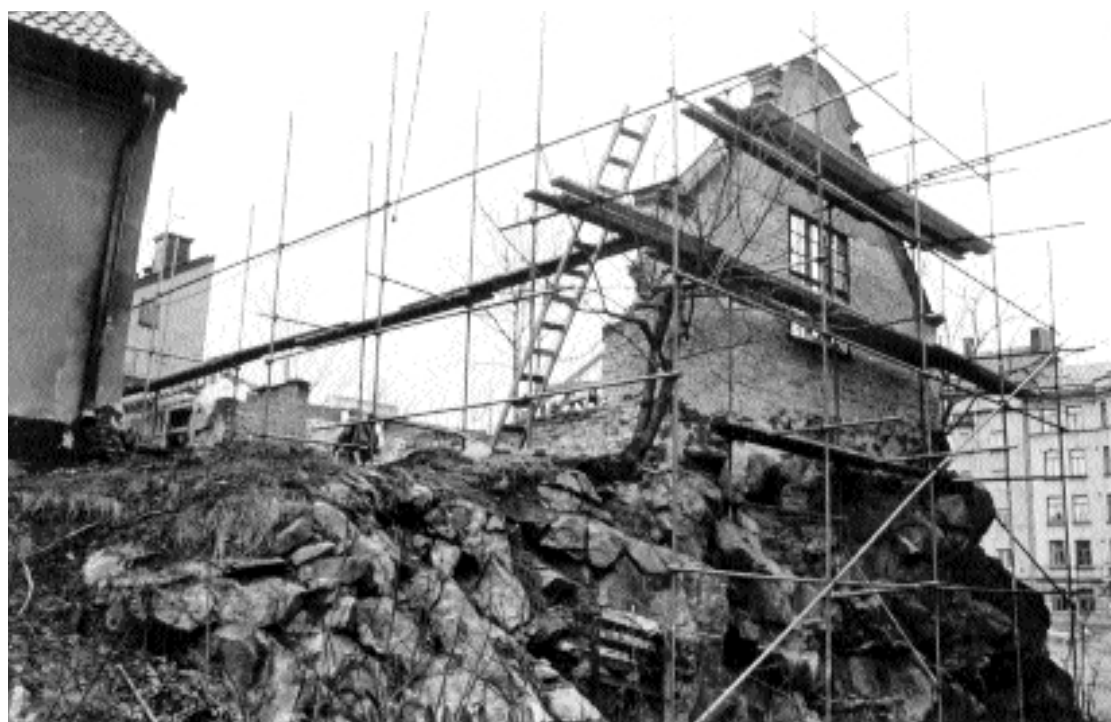
Endast gavlarna och nedre delen av de långa murarna ingår i den år 1973 rekonstruerade norra flygeln.
