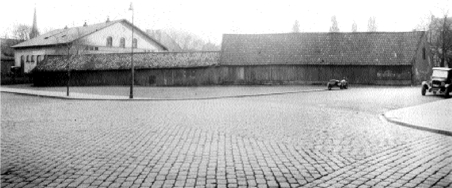
En täckt repslagarbana från 1800-talets början fick göra tjänst som stall under den tid då Livregementet – och senare Positionsartilleriregementet – var förlagda till kvarteret. Den del som återstod efter Linnégatans framdragnings revs 1929. Foto samma år.
