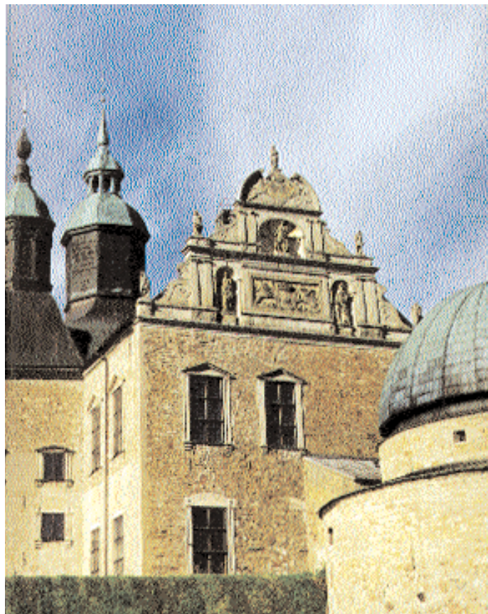
Östra praktgaveln med hertig Johans vapen och namnchiffer utförd under ledning av Hans Fleming 1602–12.
