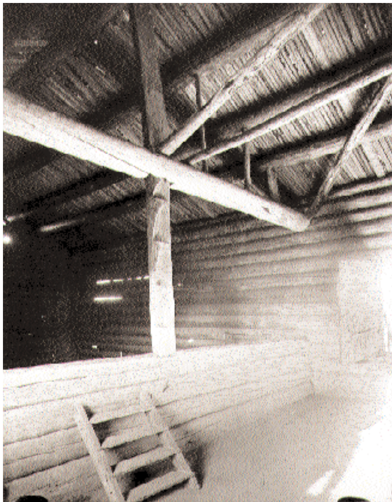
Interiör 1926. Bilden är tagen från tröskgolvet med logbalken som delar av. I mitten klivstocken.
