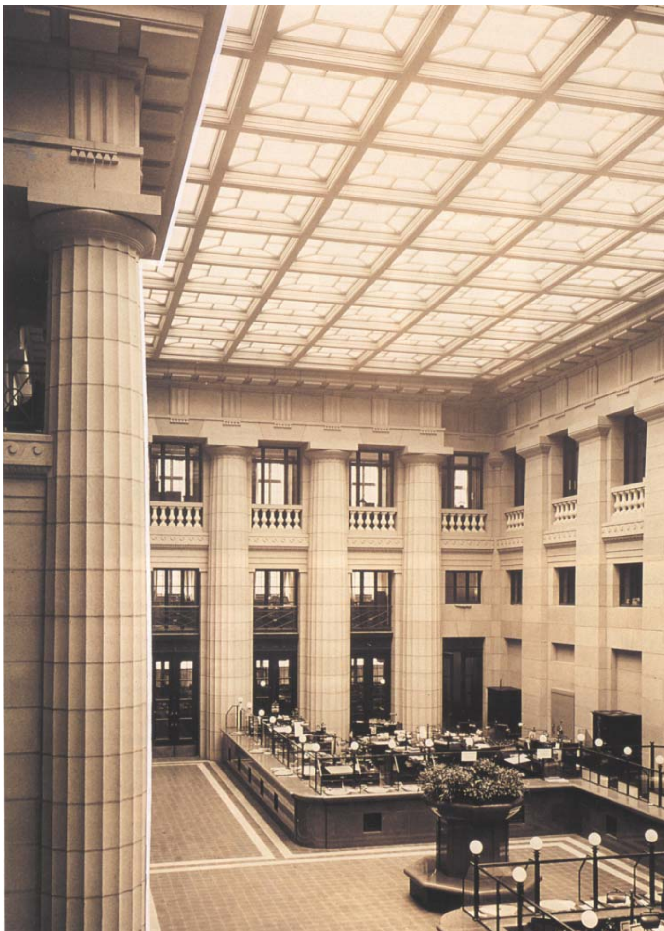
Den stora bankhallen upptar hela gården. Bankdisken var av mörkgrå polerad kalksten liksom luftintaget som var utformat likt en torgbrunn. Fönsteröppningarna släppte ljus in till kontorsrummen via det enorma glastaket. Bankhallen byggs nu om till utställningshall för Dansmuseet.
