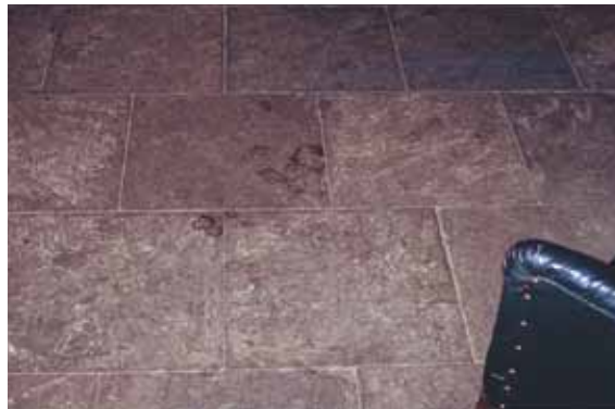
Rödvinsfläckar på ett stengolv dagen efter festen. Allt spill måste åtgärdas omedelbart, annars kan det vara för sent. Man kan förebygga detta genom att inte tillåta att folk går omkring med rödvinsglas under fördrinken. FOTO: LISA NILSEN.
