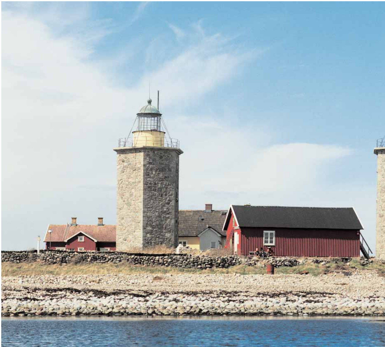
Nidingens båda sexkantiga granittorn stod färdiga 1834, och samma år byggdes också det första riktiga bostadshuset för fyrvaktarna.
