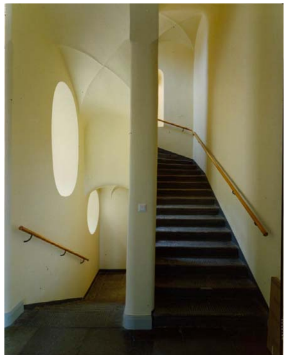
Trapphusen bör så långt som möjligt hållas fria från avgränsande dörrpartier. Foto Åke E:son Lindman
