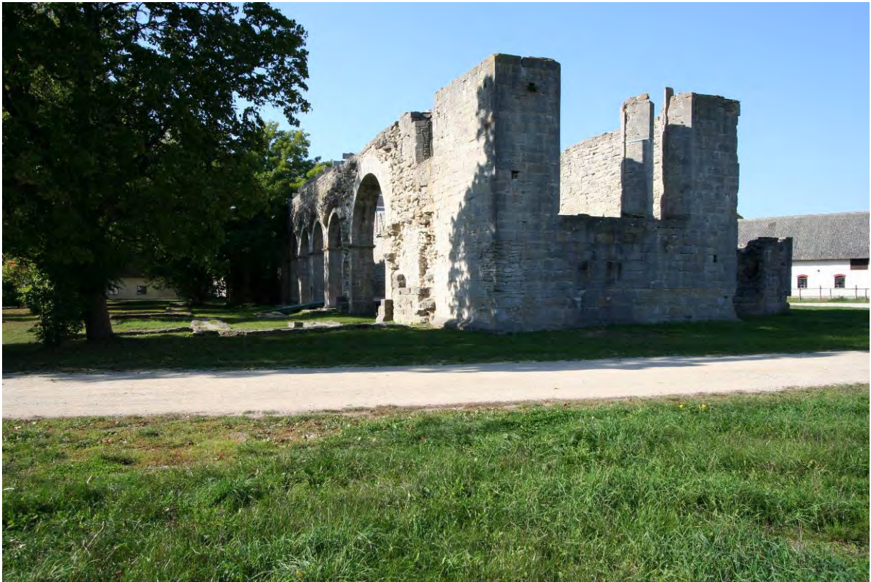
Klosterruinen från sydost med ladugården i bakgrunden.
