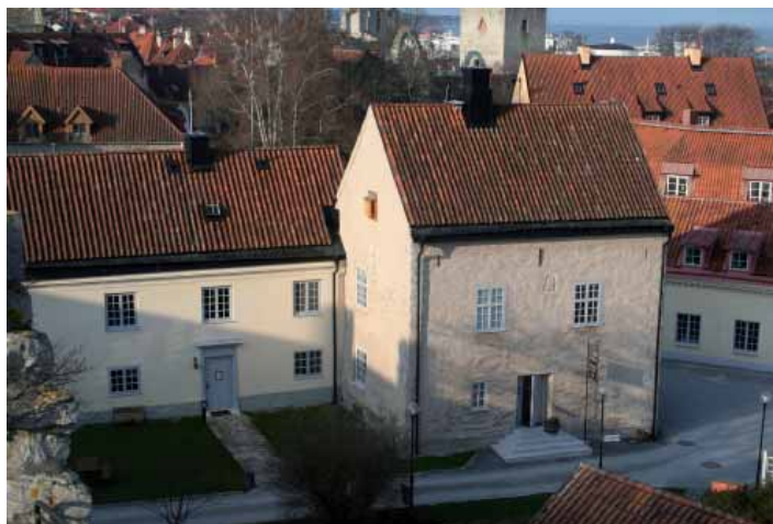
Hotellet ligger alldeles intill ruinen av Helge And's medeltidskyrka. Från tornet syns tydligt den lägre 1600-talslängan och det högre 1200-talshuset.
