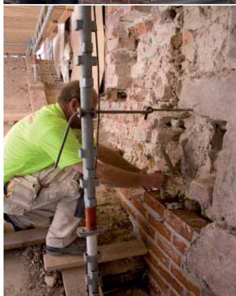
Skadade delar av muren renoveras med massivt handslaget tegel.
