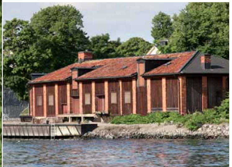
Kolskjulet, den oansenliga byggnaden på Kastellholmen, är i själva verket ett av holmens intressantaste hus och ett teknikhistoriskt minnesmärke.
