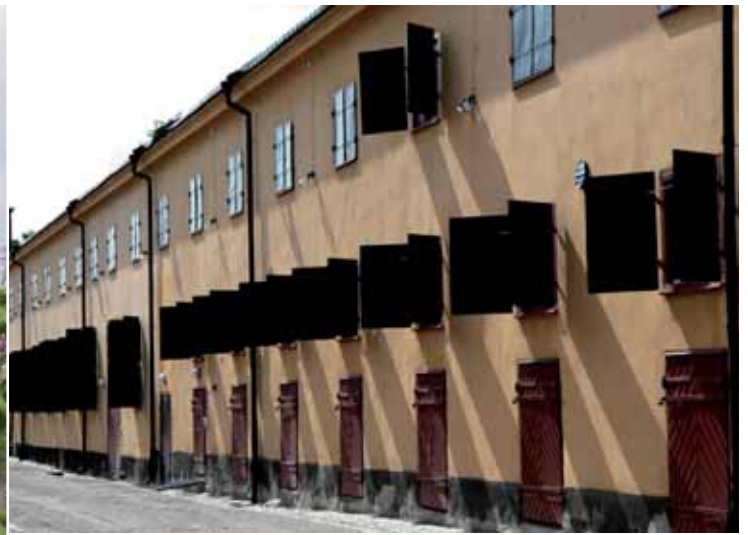
Tyghuset som byggdes som repslagarbana, och som en gång skulle bli stall, har i om- och påbyggt skick fungerat som förråd för utrustning till flottans fartyg under större delen av sin tid. I dag rymmer det Östasiatiska museets samlingar.
