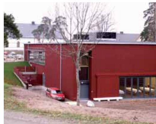
Knytpunkten – en rödmålad anspråkslös 'kub' ritad av AQ Arkitekter – är det nya navet på Strömsholm.
