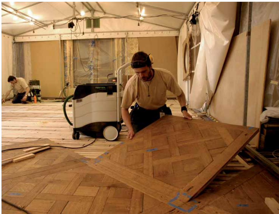
Golvet i galleriet består av 300 kvadratiske parkett-tavlor som är fästade med spånt i varandra och bildar ett vackert mönster.
