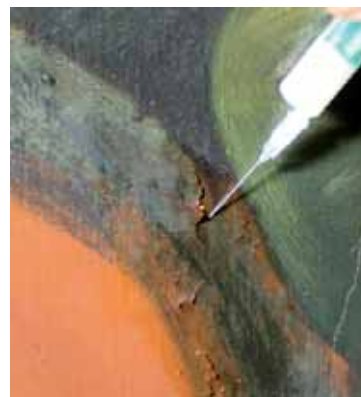
Lim applicerades partiellt under varje färgflaga. För att få limmet att tränga in bättre har ytan förvättits med alifatnafta.
