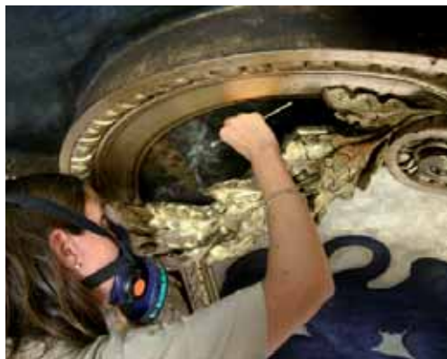
Avlägsning av fernissa med lösningsmedel.
