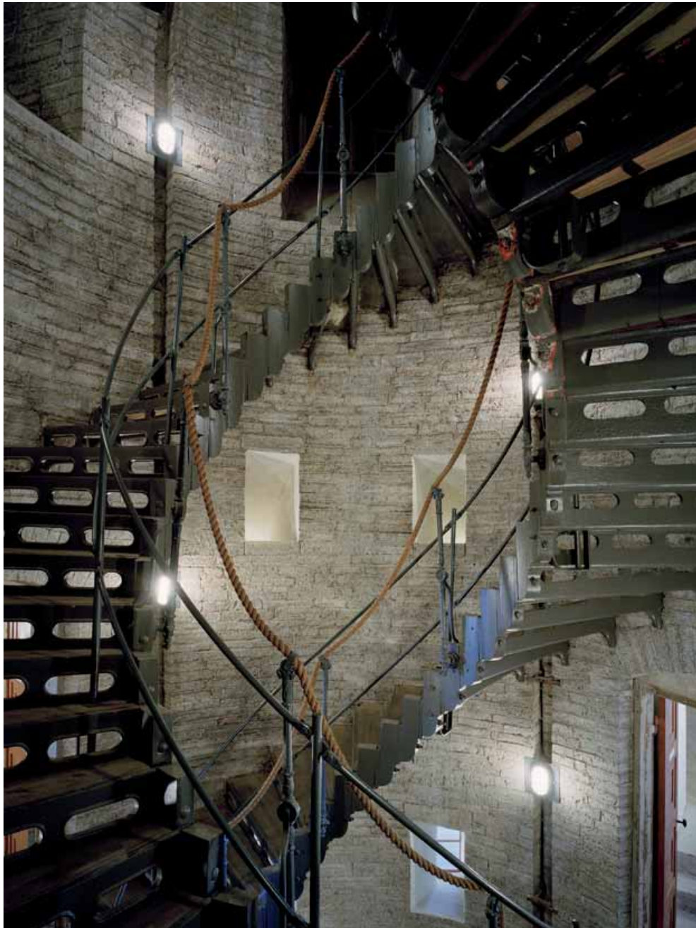
Tornets inre upptas av en dubbel spiraltrappa som likt en jätteskriv förenar de olika våningarna och halvvåningarna.
