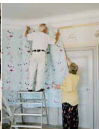
Montering av tapeter på trälistor.
