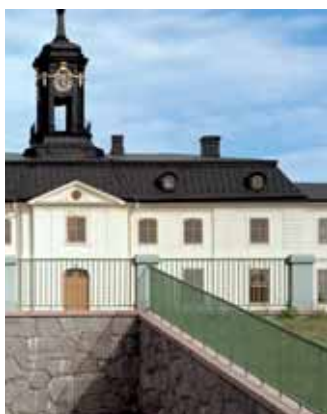
Den återuppförda rampen och den återställda fasaden.
