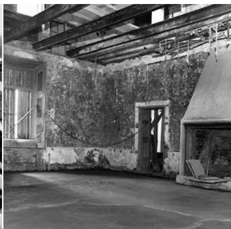
1970-talets betonggolv och stålbalckförstärkningar.
