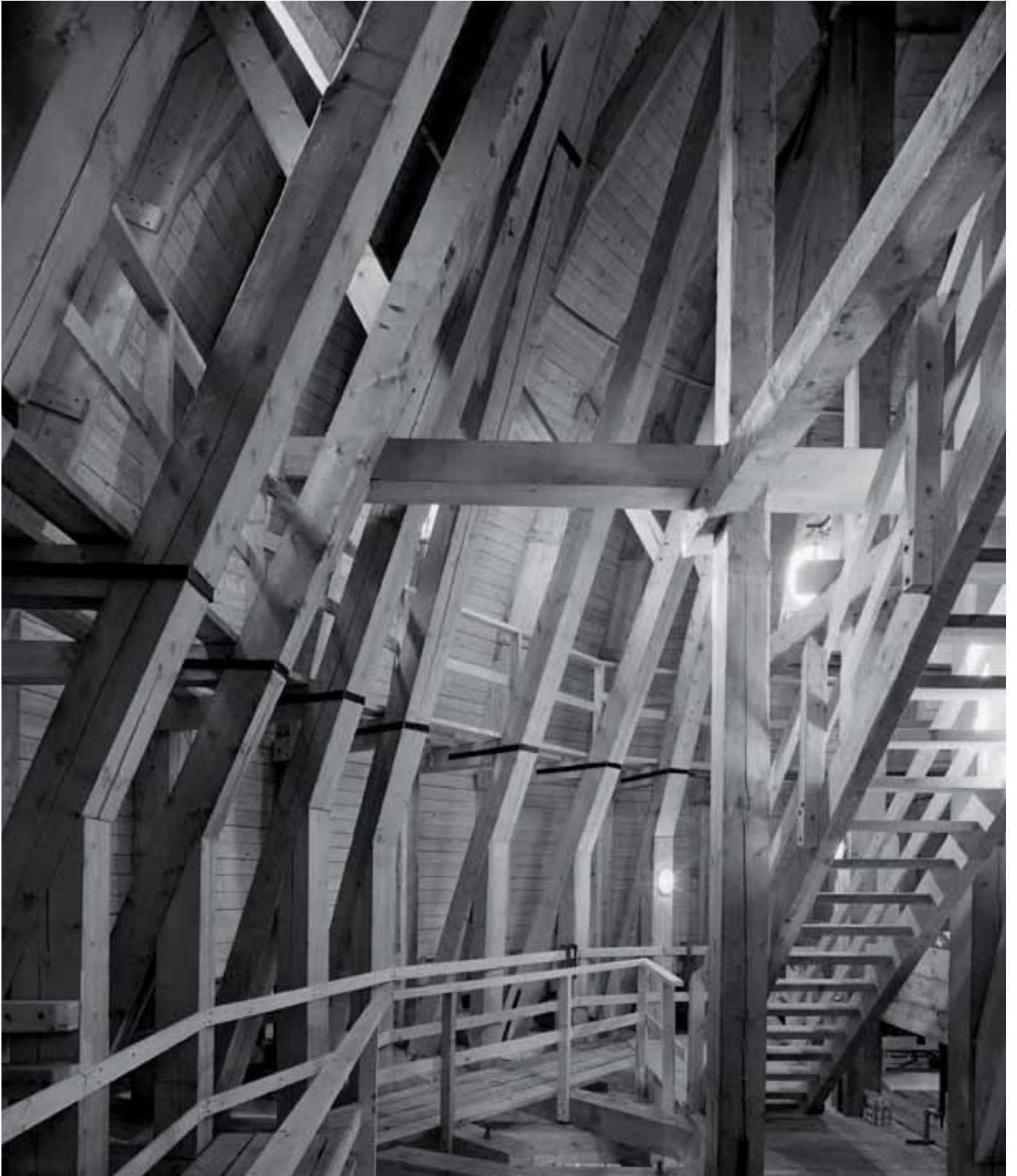
Katarina kyrka. Ny takstol av sågat timmer – man avstod från att bila. Det är ett återskapande i konstruktivt hänseende, ett återställande av funktionen med rätt styvhets- och styrkeförhållande mellan murverk och träkonstruktion. Genom att inte bila timret visar man att det inte är den gamla takstolen.
