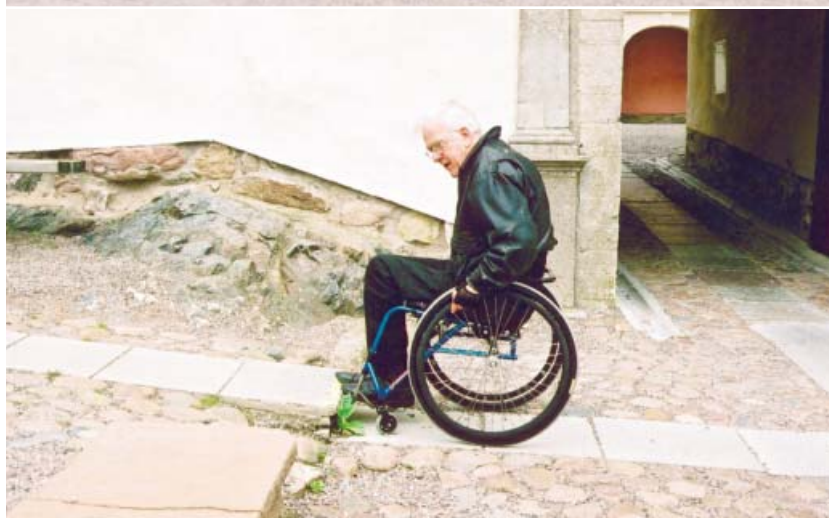
Enkla åtgärder som att göra kalkstensgången över kullerstenarna dubbelt så bred påverkar inte den historiska upplevelsen av slottsmiljön på Läckö, men skapar helt andra förutsättningar för tillgängligheten.
