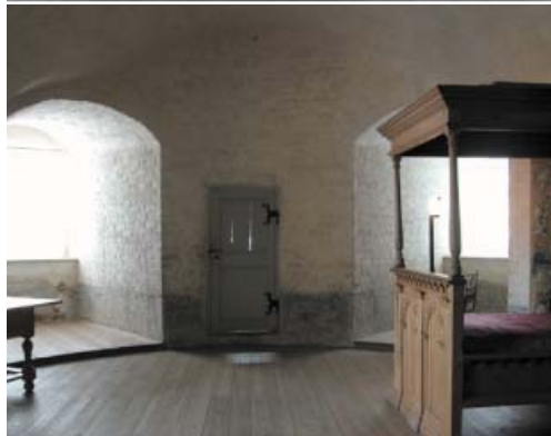
Gustav Vasas sängkammare före och efter Hakon Ahlbergs restaurering 1950.
