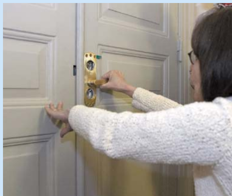
När man tar i handtaget ska man kunna komma in genom dörren. En tung dörr är besvärlig för alla.
