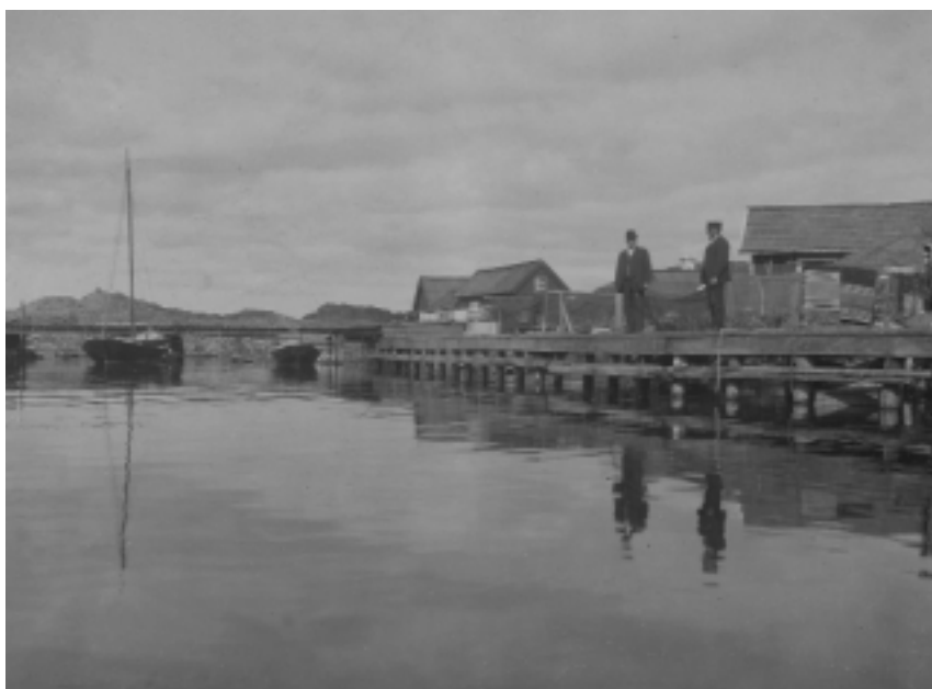
Under 1800-talet anlades permanenta kajer och bryggor där lotsbåtarna tidigare dragits upp på stranden.
