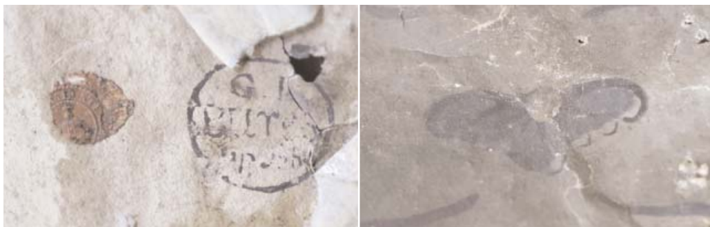
På baksidan till ett av de historiska tapetfragmenten har man funnit två stämplor som knyter tapeten till Uppsala och tiden då Linné bodde på platsen.
