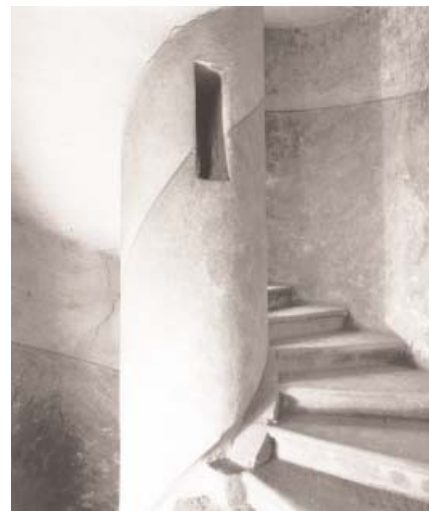
Den ursprungliga spiraltrappan revs 1955 för att ge plats åt en hiss. I mått och konstruktion var den mycket lik trapporna i hus ritade av Andrea Palladio.
