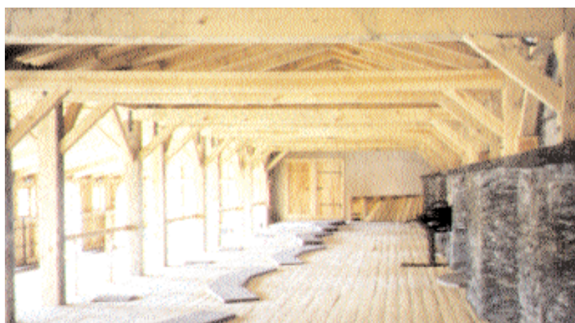
Interiör av vallgången under Västra huvudvallens rekonstruerade fredstak. Bland annat syns kanonvandringsarna för lavetternas bakre hjul och, till höger invid muren, spelet för vindbryggan till Västra kaponjären.
