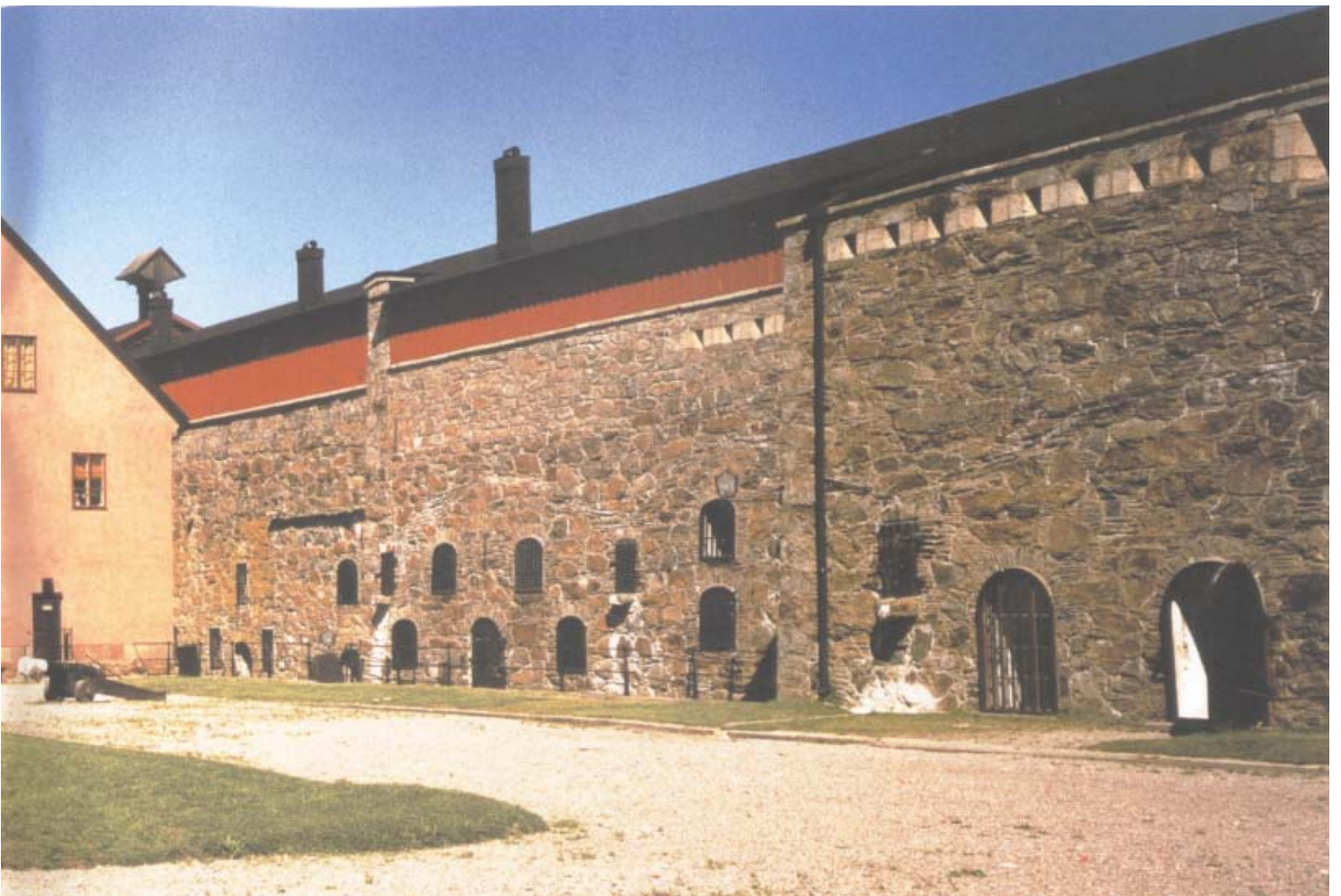
Västra huvudvallen med fredstak. Fasad mot Stora borggården.
