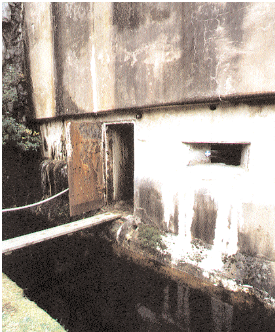
I vallgravens norra och södra vinklar finns så kallade kontreskarp-gallerier varifrån man kunde skjuta i gravens längdriktning. Galleriet skyddas av ett framförliggande vattenhinder, en så kallad diamantgrav.
