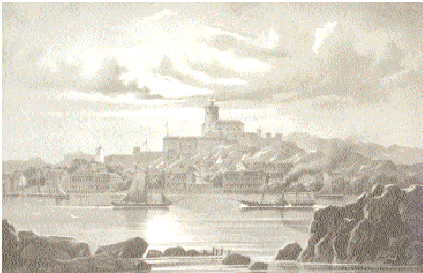
År 1781 uppfördes världens första rundgående fyr på tornets överbyggnad. Fyrljuset svepte runt horisonten med hjälp av ett urverk och visade sex starka och tre svagare ljus under en femminutersperiod. Fyren byggdes om 1836 men släcktes för gott 1868. Litografi från mitten av 1800-talet.
