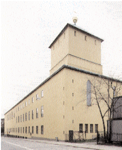
Den långa norra längan mot Linnégatan har skenbart kortats av genom att en sjättedel av muren på var sida lämnats utan fönster.
