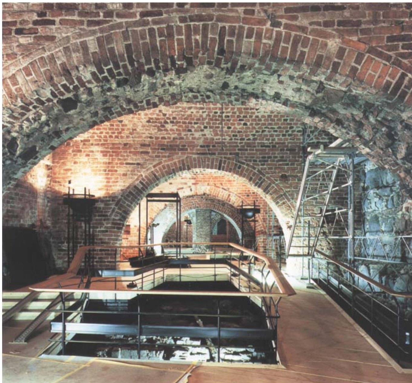
Museet under inredning hösten 1999. Som lösning på problemet med de stora nivåskillnaderna mellan rummen har museet fått ett sluttande golvplan.
