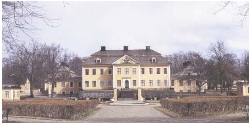
Lövstabruk i Norduppland tar sedan i våras sin värme ur marken.
