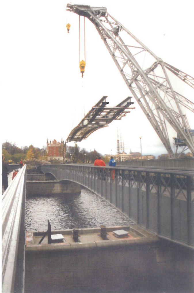
Den nya körbanan till Skeppsholmsbron lyfts på plats av Stockholms hamns pontonkran Ragnar Lodbrok.
