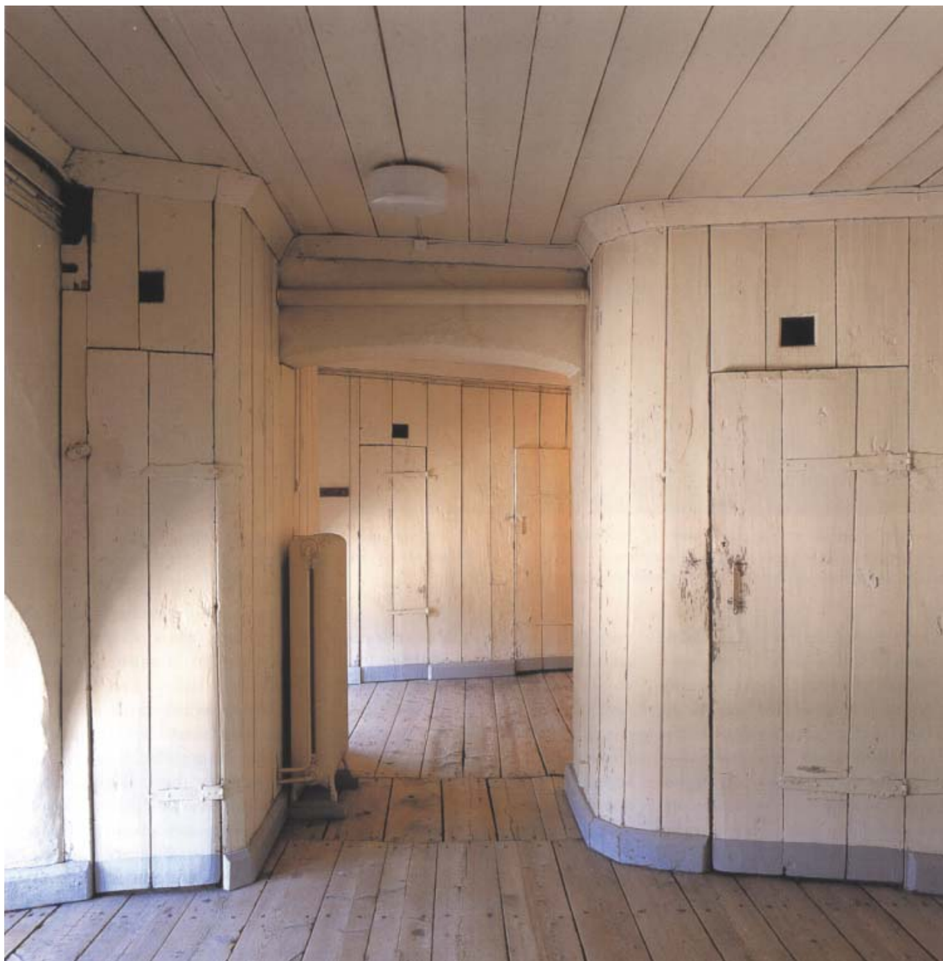
I hallen på första våningen i högvaktsflygeln lever 1700-talet kvar. I släpljuset från de halvrunda fönstren framträder de handbilade träpanelernas levande yta.
