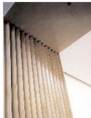
Raffinerade passager från rum till rum. Omsorgsfullt utformade detaljer, som utställningssalarnas 'veckade' björkpanel, bidrar på ett effektfullt sätt till att bryta interiörernas strama geometri.
