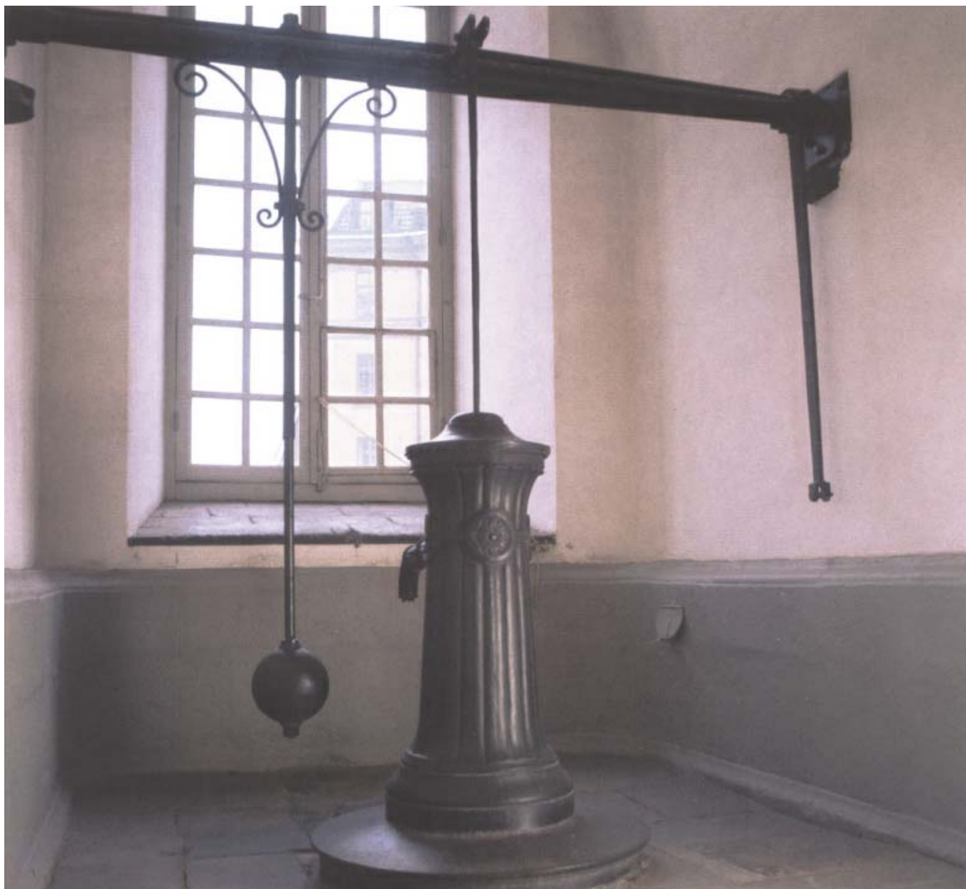
Slottsarkitekten Tessin försåg den södra längan i det nya slottet med vattenpumpar och brunnar, allt för att garantera ett fullgott brandförsvar. Brunnarna har sedan länge sinat, men pumparna har fått stå kvar och vittnar om forna tiders brandbekämpningsmetoder.
