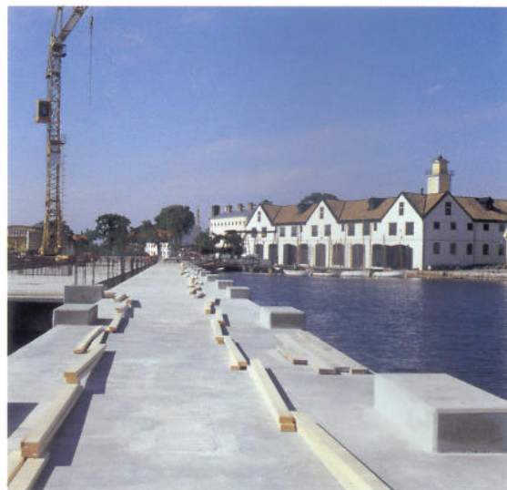
Piren är gjuten och nu påbörjas själva byggnationen av Marinmuseet. I bakgrunden syns Slup- och Barkasskjulet med sin vitputsade fasad.
