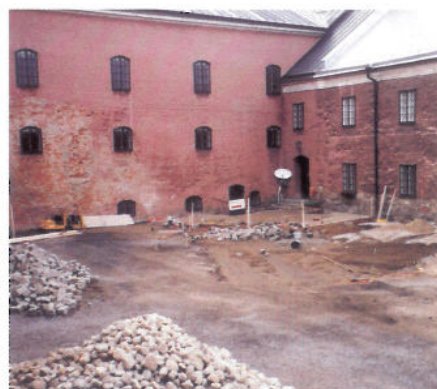
Borggården från norr, inför kullerstensläggning och fasadblästring.
