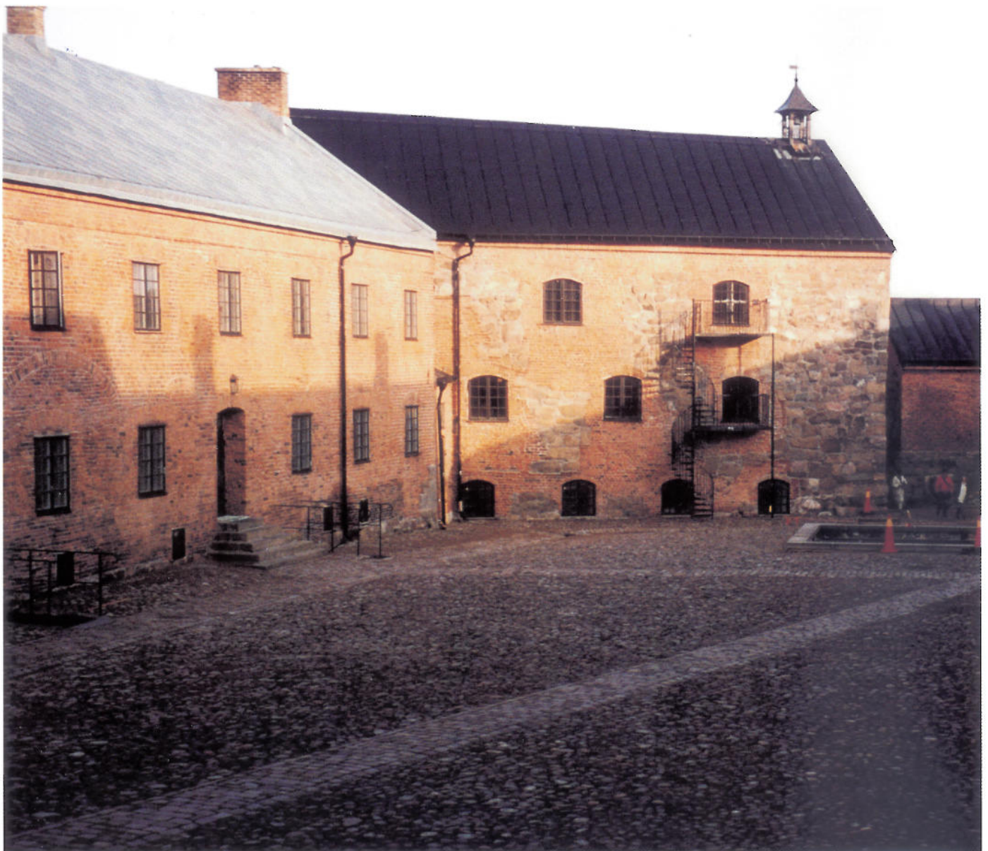
Borggården från söder efter kullerstensläggning och fasadblästring.
