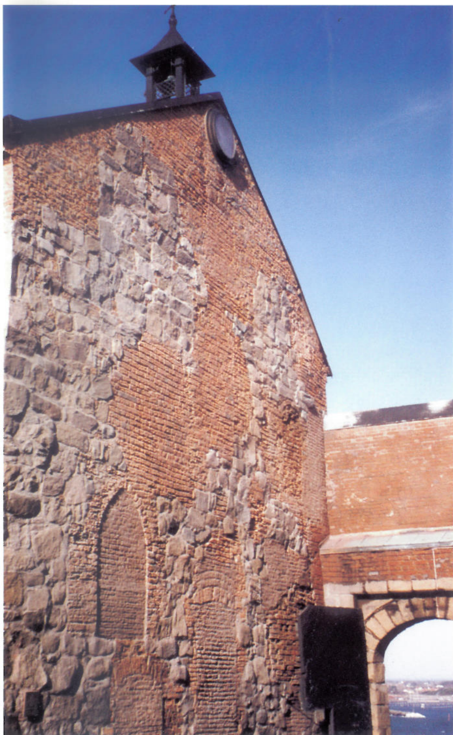
Den f.d. kyrkan eller norra längan av borggården efter fasadblästring.
