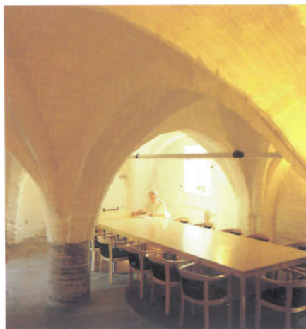
Biskop Henrik Tidemanssons borgstuga inreddes med ståtliga kryssvalv i slutet av 1400-talet. Den ligger i den del av slottets västra länga som byggdes på 1200-talet.
