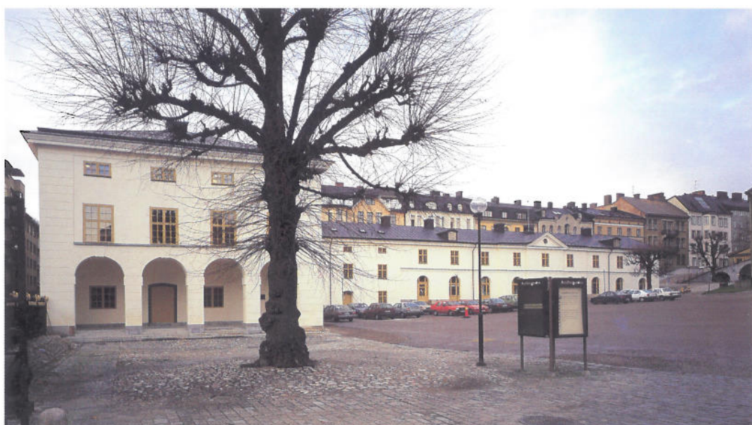
Armémuseum i Stockholm är en av många SFV-byggnader som genomgår stora renoveringar. Båda flyglarna har grundförstärkts och totalrenoverats in- och utvändigt. Uppfartsramperna till huvudbyggnaden har lagts om och nu återstår en helrenovering av tyghuset, d v s själva museibygnaden. Armémuseum är inrymt i Artillerigården vid Riddargatan, som byggdes 1763-1806. Huvudbyggnaden förhöjdes med en våning 1884.
